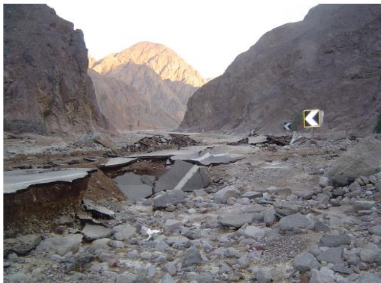
Εικόνα 3: Καταστροφές στην κοιλάδα Watir λόγω flash flood
